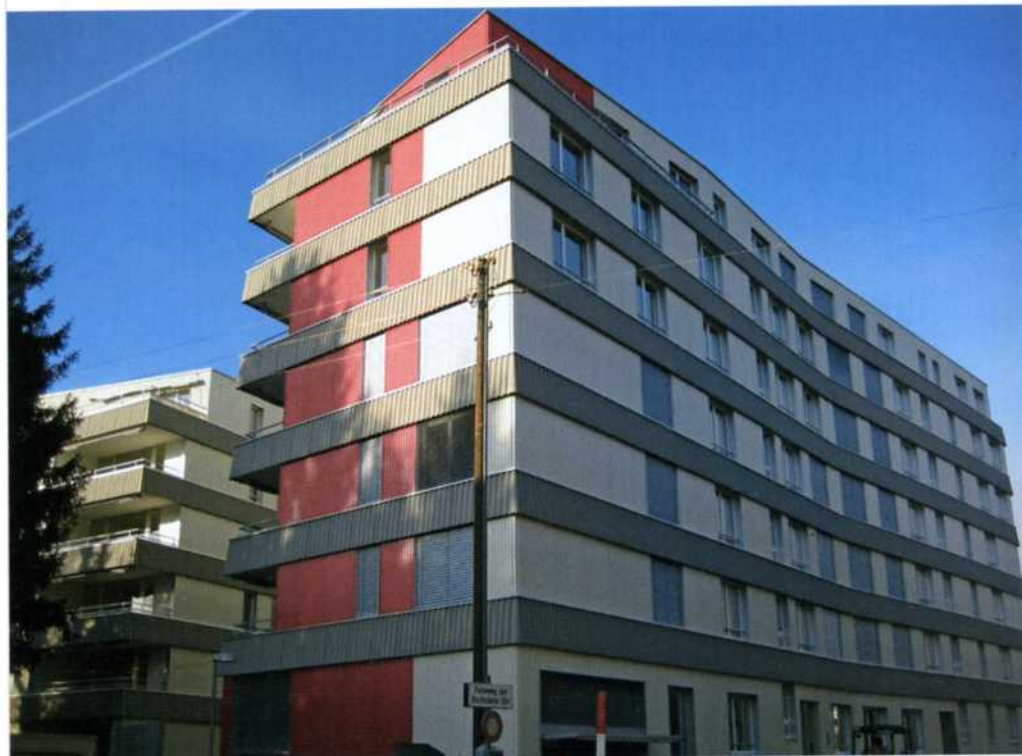
Der Querbau bildet einen Lärmriegel gegen die Farbhofstrasse und setzt im Quartier einen kräftigen roten Akzent. Ein leicht ausgestelltes Welleternitband säumt die Fassade.
