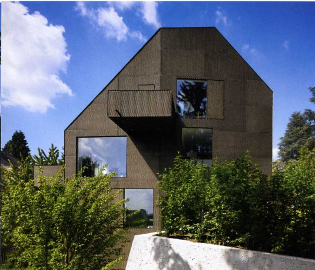
Fassadengestaltung und Fenstereinteilung verschleiern sowohl die Geschossigkeit als auch die innere Raumverteilung des Doppel-einfamilienhauses.
