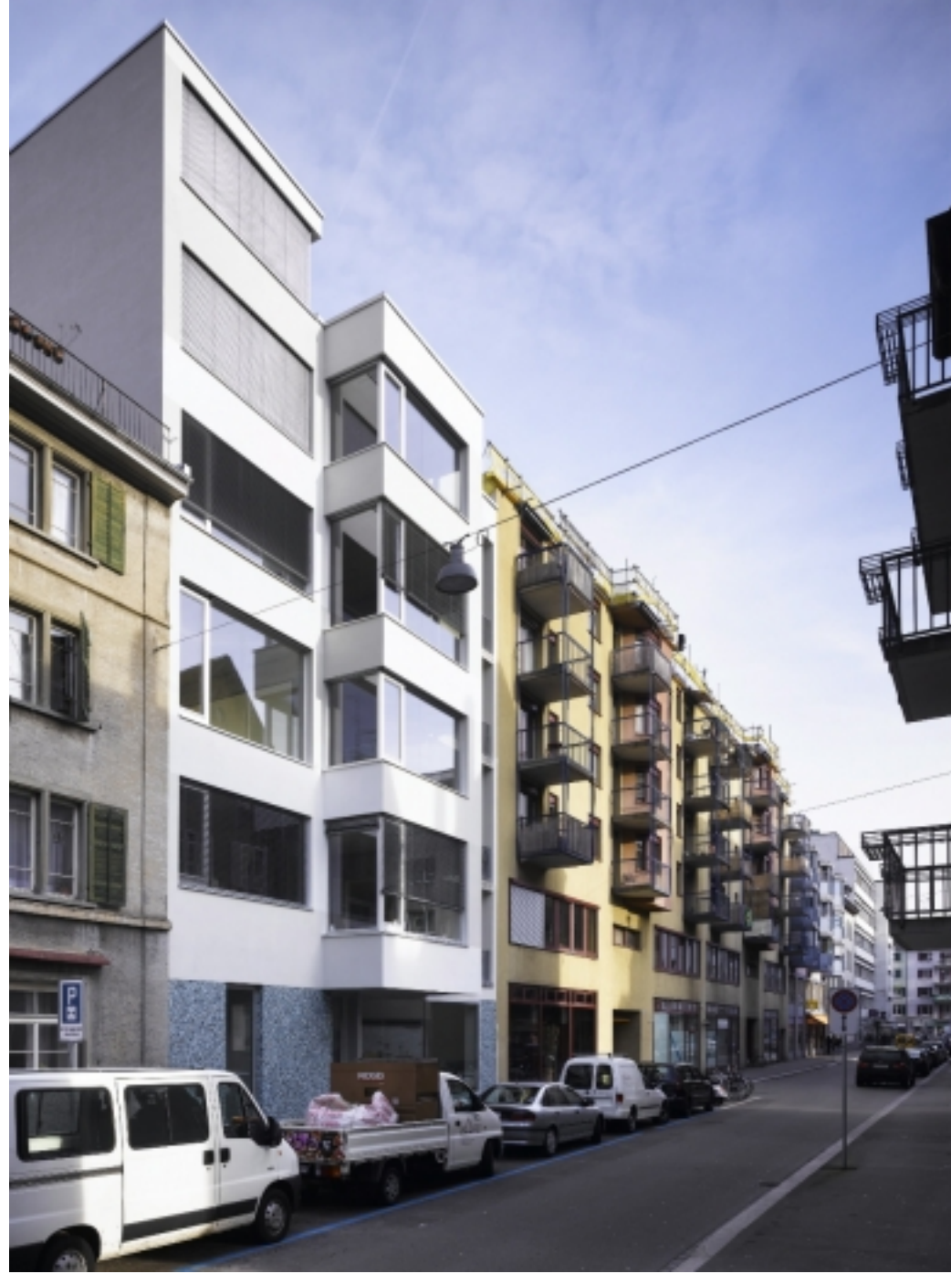
Ansicht Sihlhallenstrasse (Foto:Hannes Henz)
