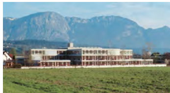
Erweiterung und Renovation eines Schulhauses von Viktor Hufnagel, Wörgl, Österreich, 2003
